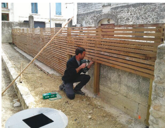
Parc Habillage de bois du mur.
