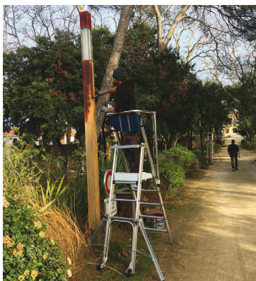
Parc municipal Peinture des mâts d'éclairage
