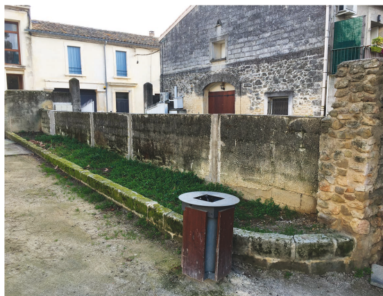
Parc Photo AVANT l'aménagement
