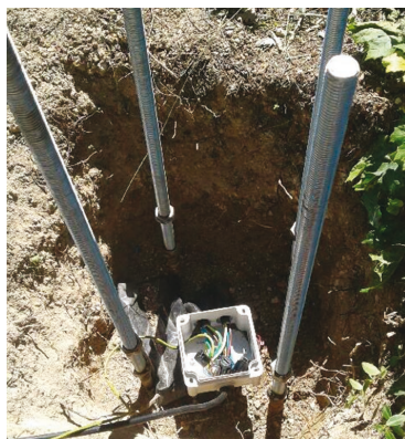
Parc municipal Réfection des mâts d'éclairage
